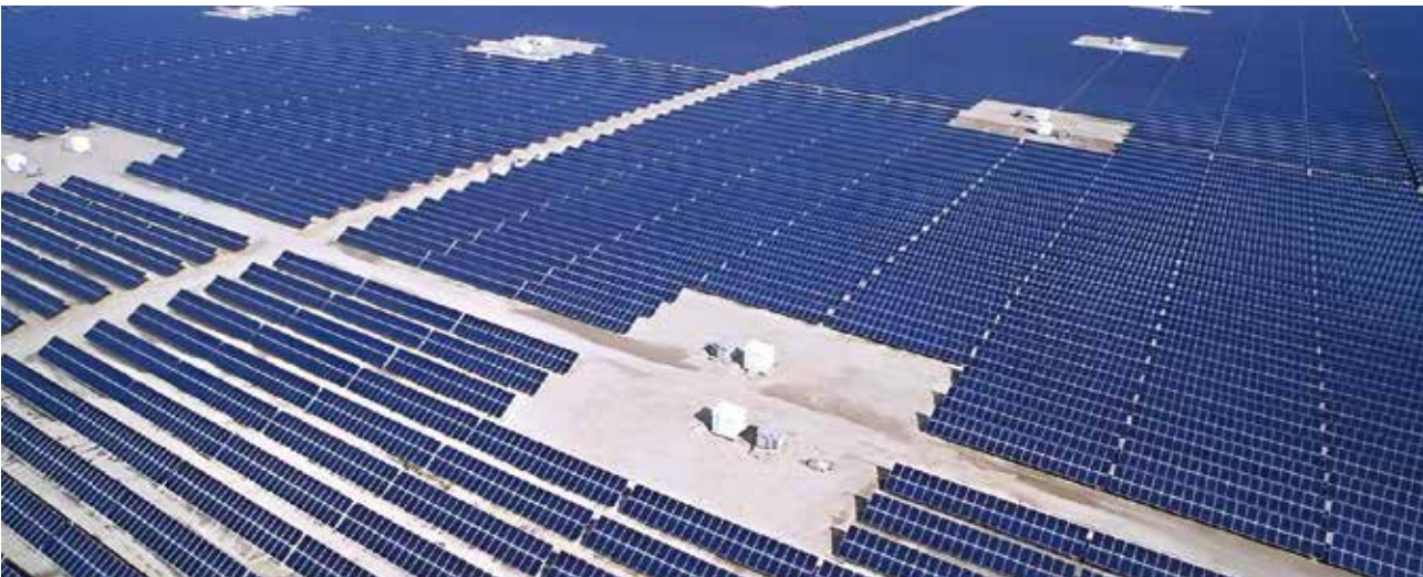
04 Proyecto Utility en la planta fotovoltaica de 900MW en Pakistán
