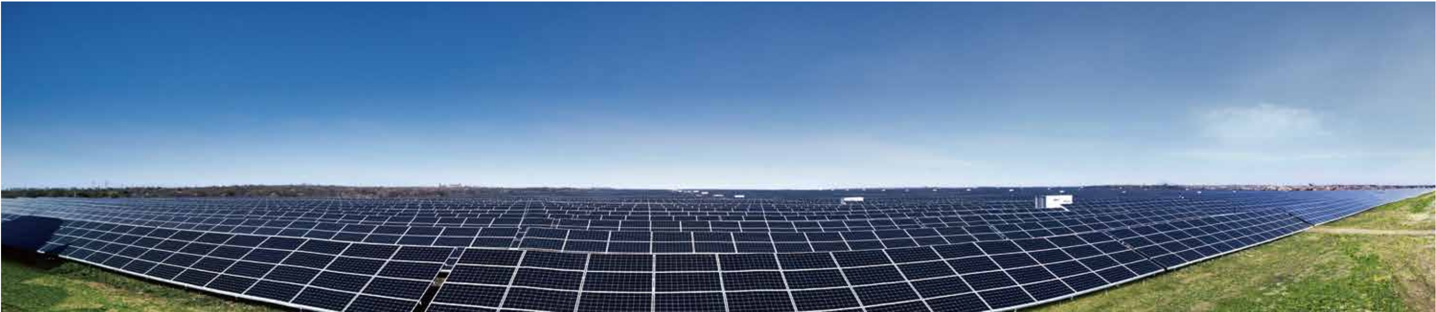
01 Proyecto Utility en la planta fotovoltaica de 240 MW en ucrania
