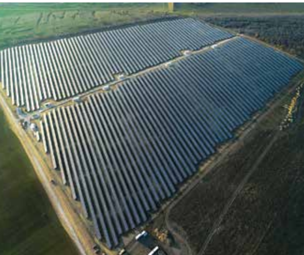
08 Proyecto Utility en la planta fotovoltaica de 15 MW en Ucrania
